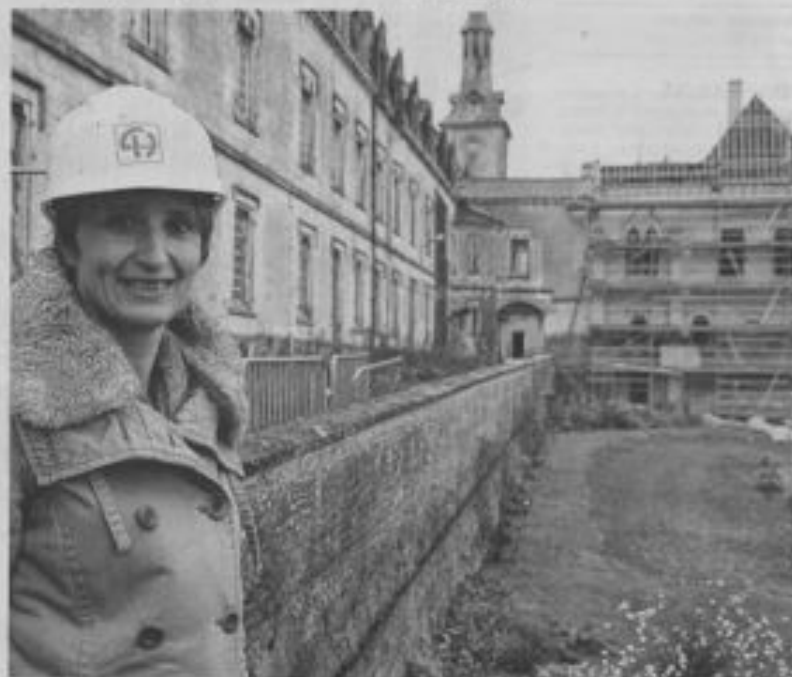
Alexia Noyon, la directrice de l'association, posant devant les échafaudages. Signes enfin concrets que d'ici trois à quatre ans, l'édifice sera rénové et transformé en équipement touristique et culturel important avec résidence hôtelière sur place.
