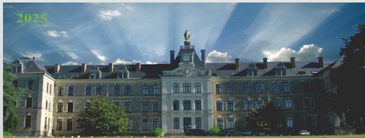
Bâtiment principal historique
