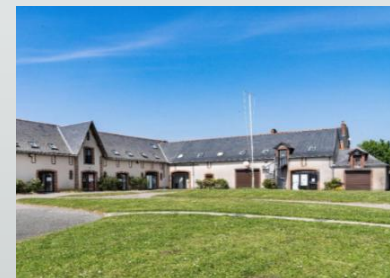
Ancienne ferme réhabilitée
